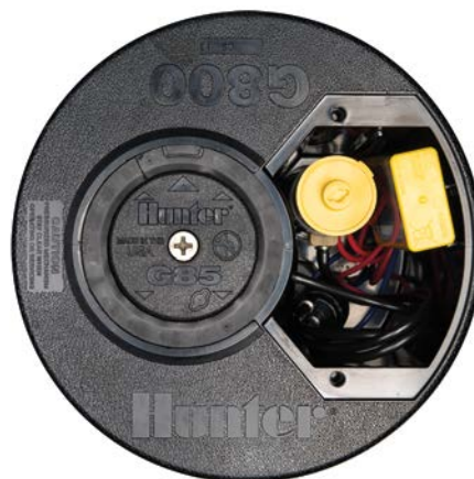
Ротор TTS G-885 с декодером в головке
